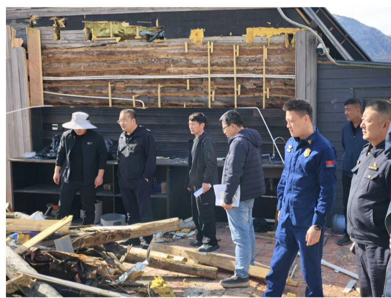
地区启动安全生产综合检查，工作人员下沉各县市全覆盖督导。地区应急管理局供图
