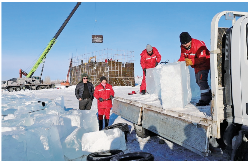
工作人员加快推进冰雕塑形工程建设。
