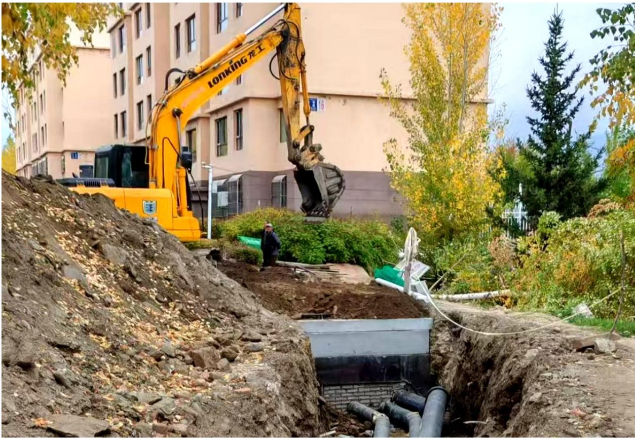
换供热管网14850米,更换给水管网9140米。目前供热新管网已全部投入使用;给水老管网与新管网同时使用,新管网与单元入户管需碰头合计144个,目前已完成60个,其余碰头正在施工中,预计11月初自来水新管网全部投入使用。
